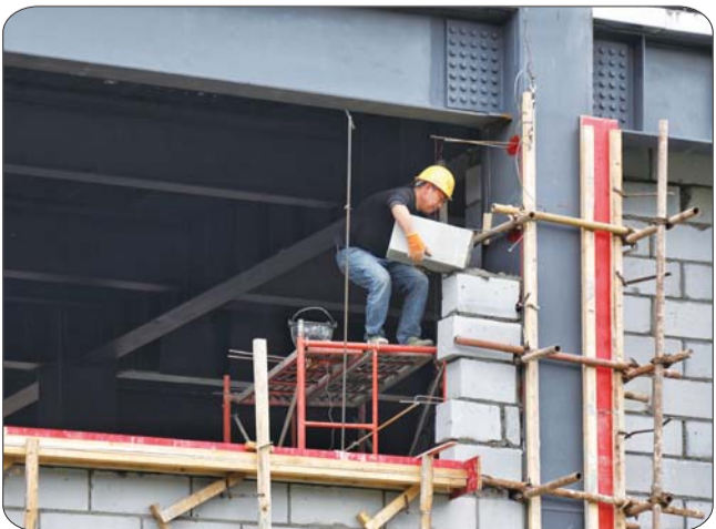
宿舍楼正在进行内墙砌筑。
