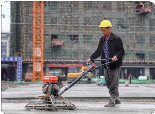
工人正在利用磨光机平整地面。
