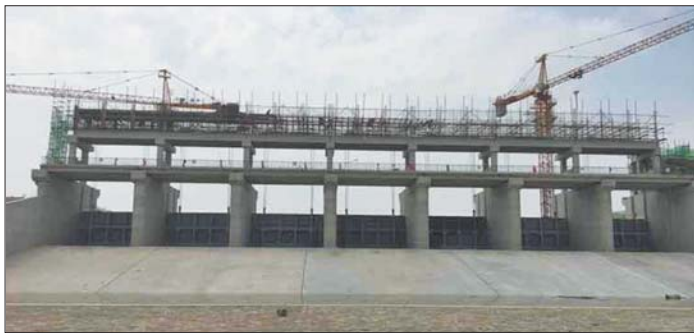
柴庄节制闸施工现场。
