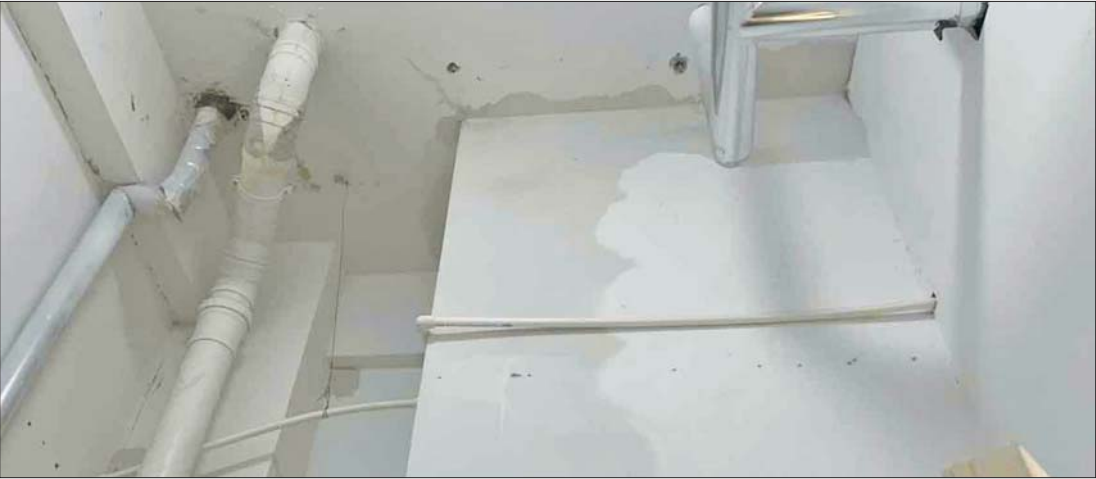
房顶漏水痕迹明显。
