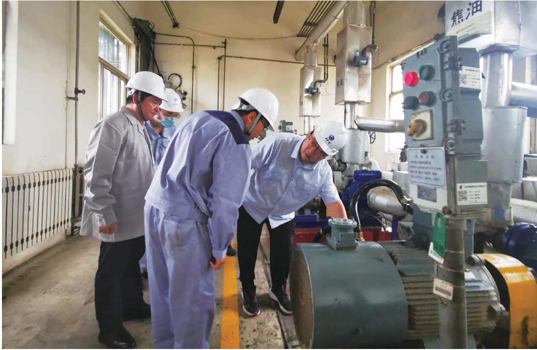
在山东杰富意振兴化工有限公司,省应急厅执法人员对问题整改情况进行现场核查。
