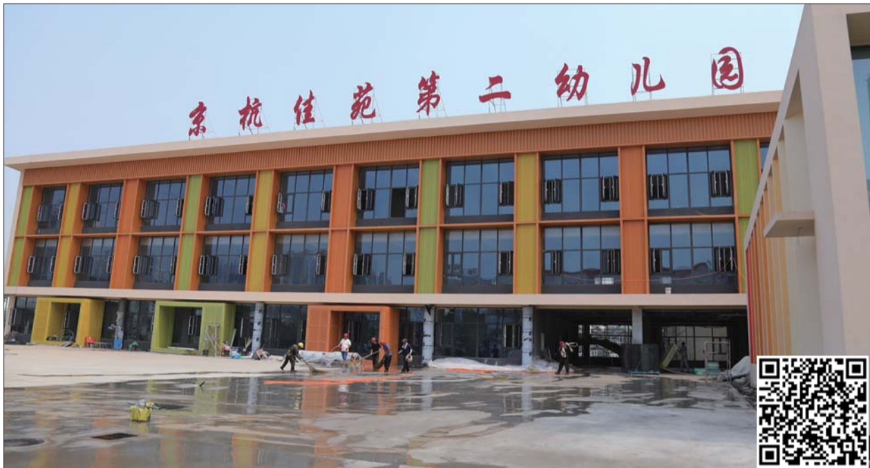
京杭佳苑第二幼儿园项目预计今年7月底可竣工。
