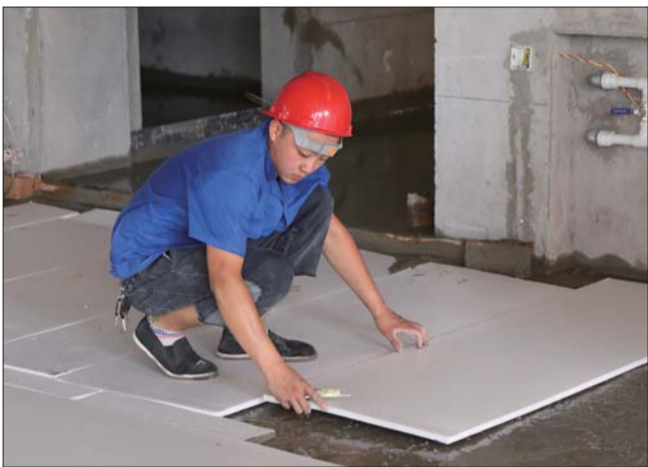
施工人员紧张忙碌。
