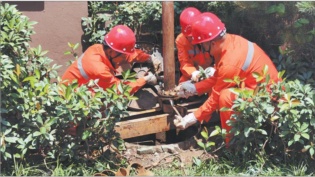
施工人员正在封停唐冶中学校园内的自备井。
