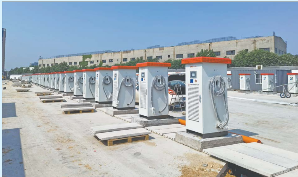
在建中的新能源汽车充电停车场。
