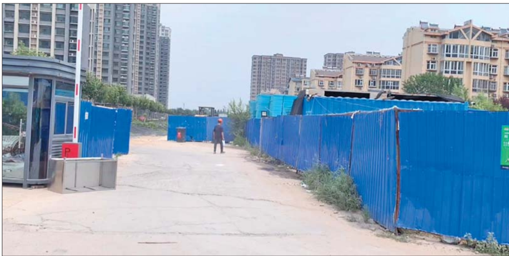
滨州玉龙苑小区还在建设中,业主通行有些不方便。
