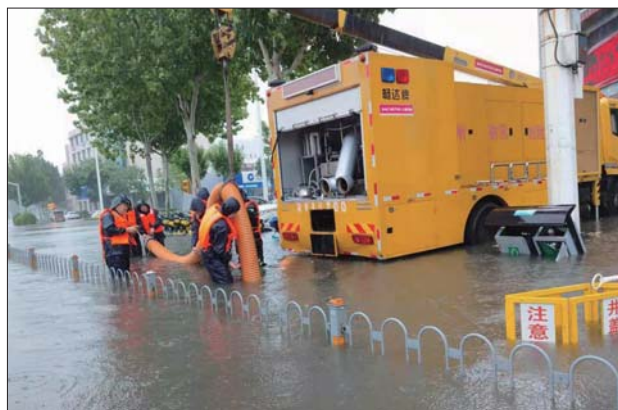
在东来顺路口,德州市政管理人员在水中利用防汛抢险车抽水,防止地下井水倒灌。
