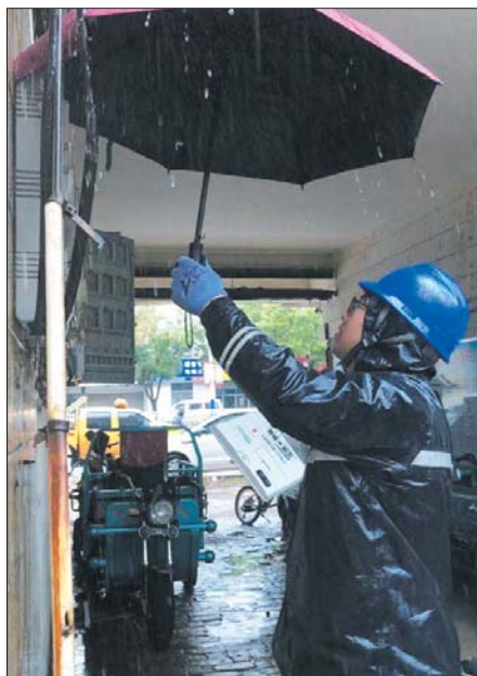
上午10时,德州供电公司工作人员抢修室外电表。
