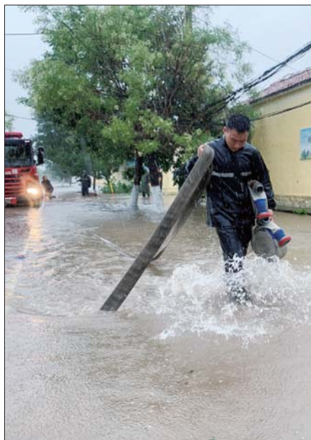
上午9时46分,德州消防在二屯镇后园村排涝,现场水位约40厘米。
