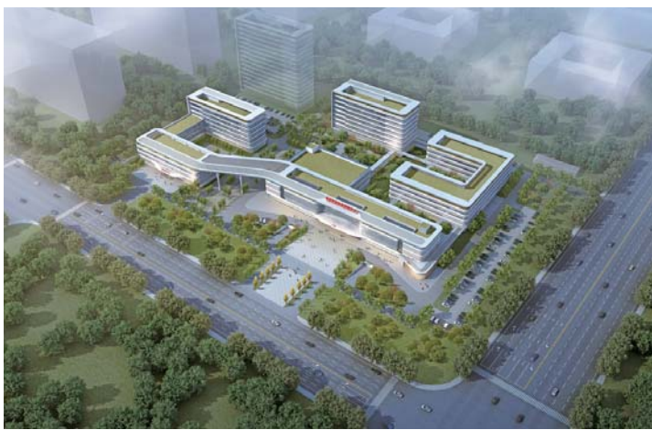
建设中的德州东部医疗中心。
