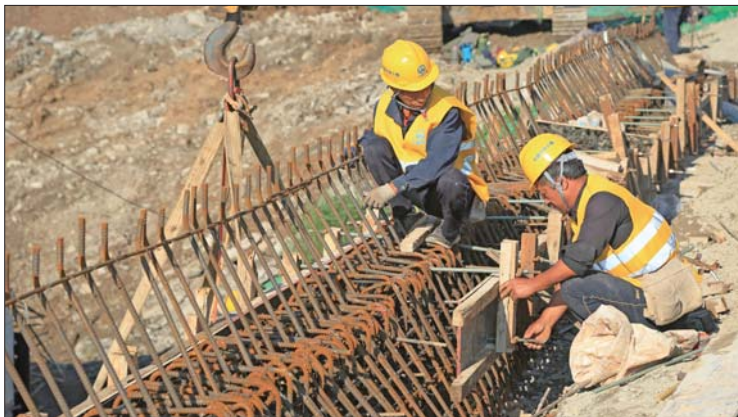
工人在国道309现场浇筑防撞墙。
