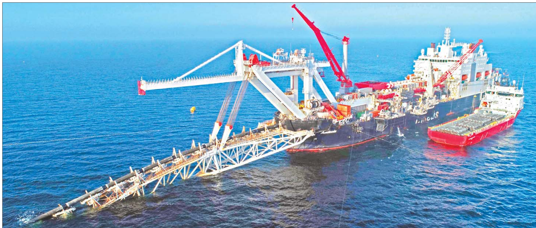
9月6日,“北溪-2”天然气管道项目第二条支线的最后一节管道完成焊接。图为在德国水域海底铺设管道的资料片。 新华/法新
