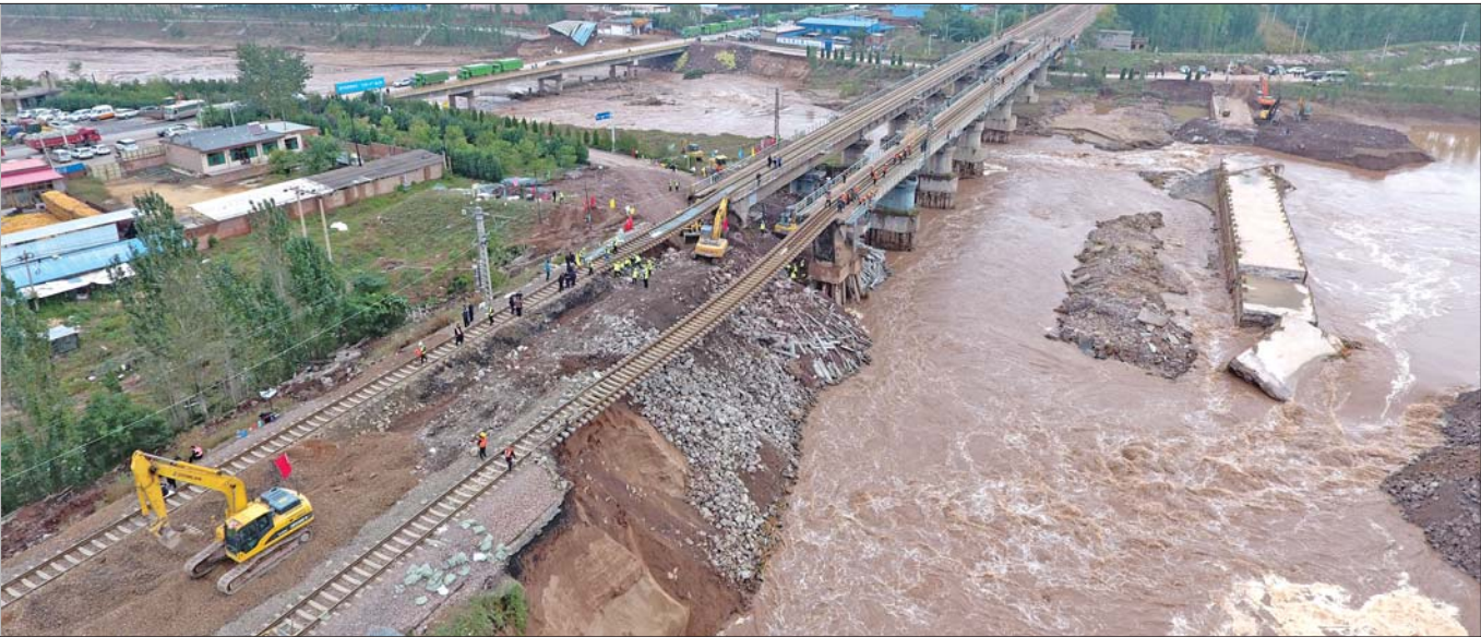
10月6日,受强降雨影响,山西省祁县境内昌源河水位上涨,洪水冲毁路基,导致南同蒲铁路昌源河大桥铁路悬空,铁路中断运行。 新华社发
