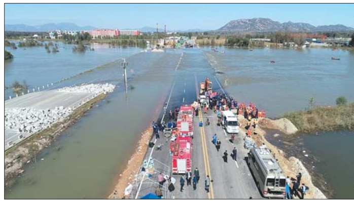
通勤班车涉水倾覆事故现场。
