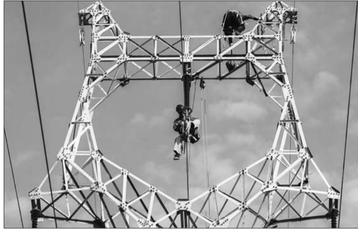
彩虹服务队正在检修供电设施。
