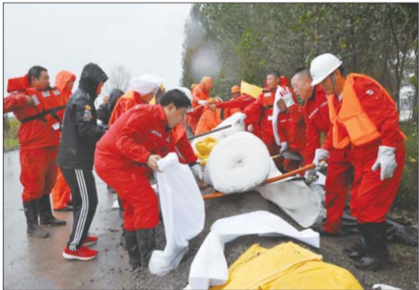
滨南采油厂等单位支援利津堤坝加固工作。
