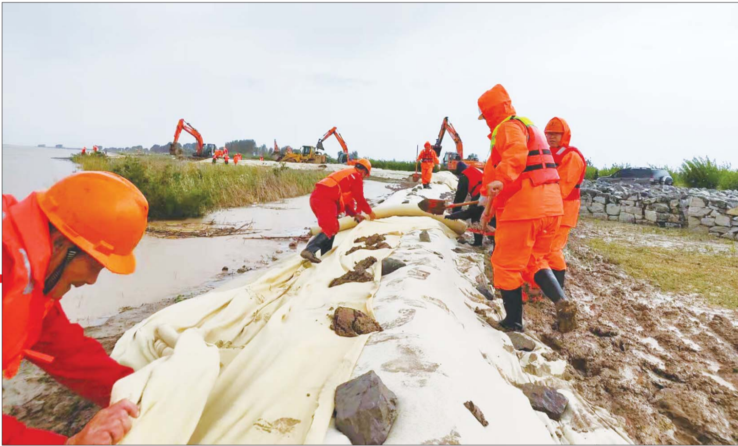
孤岛采油厂应急抢险队伍修筑子坝。
