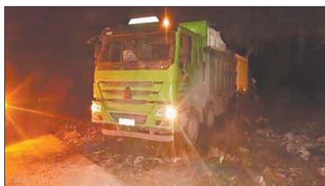
运输车正在往沟渠内倾倒建筑垃圾。
