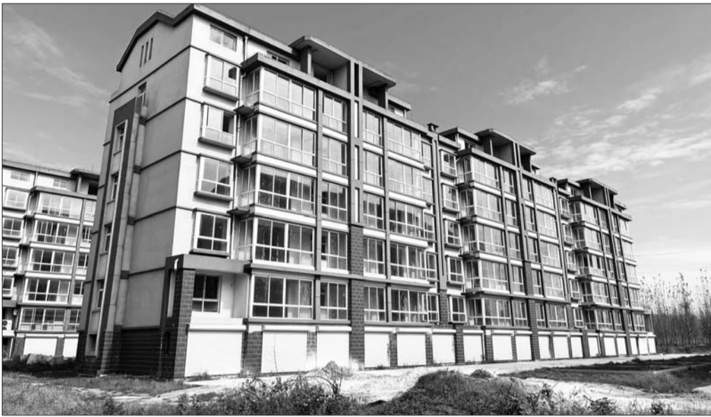
安置房已经建成,工地长满杂草。
