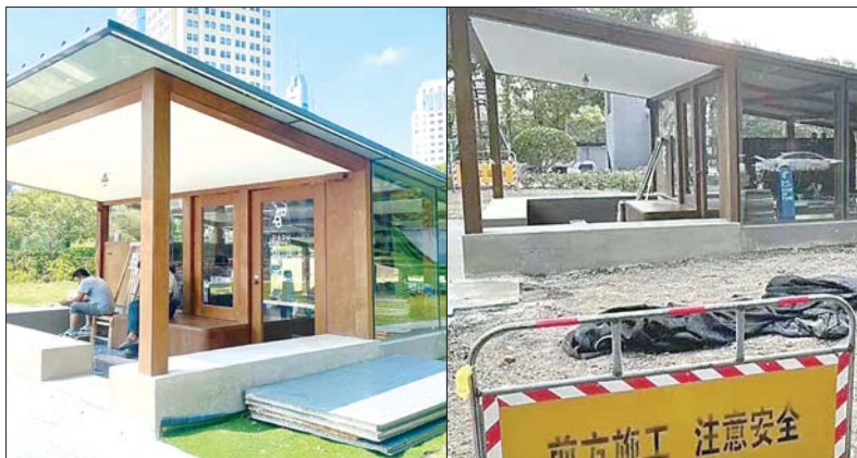
地铁口下沉式新晋咖啡店旁边还是未施工完成的地铁工地。
