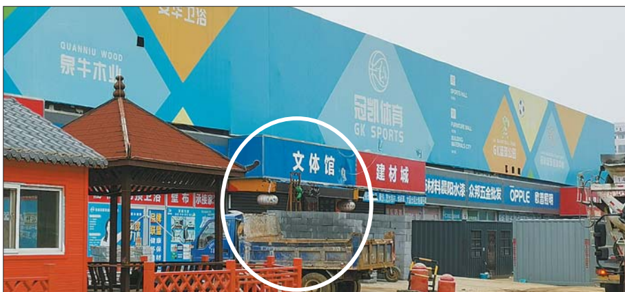
市场内的文体馆(圆圈所示)已被围挡,正在施工。
