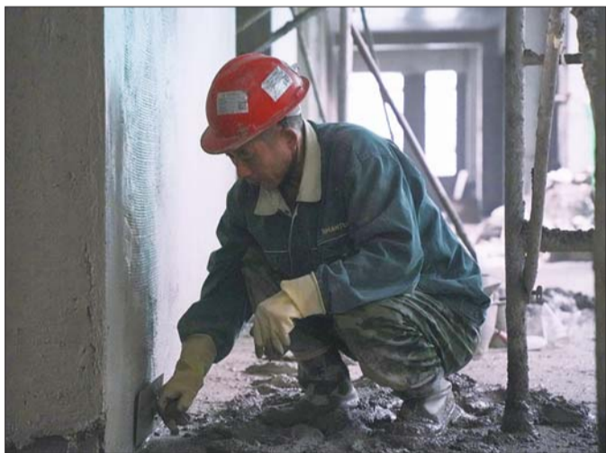
项目内部正在进行施工。
