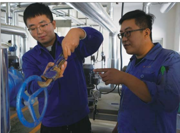
运河热力工作人员正在检修阀门。
