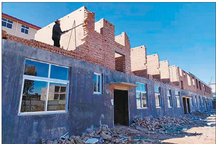
助力2000余平方米违建顺利自拆。
