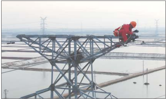
员工正在紧固铁塔螺栓。 通讯员 颜曾 摄
