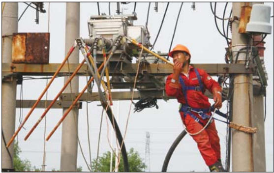
员工正在登杆挂接地线。 通讯员 姜薇 摄
