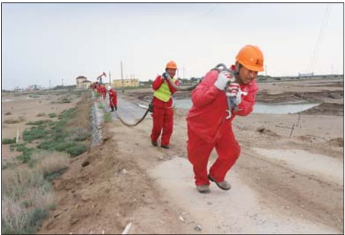
员工齐心协力敷设电缆。 通讯员 吴建东 摄
