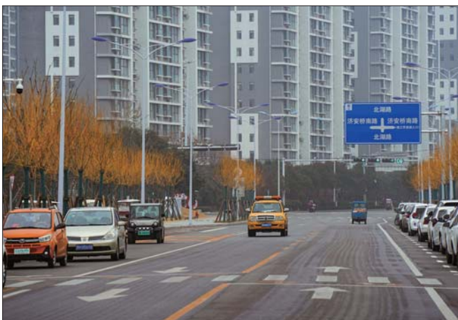
济宁天立学校门口的北湖西路西延工程。
