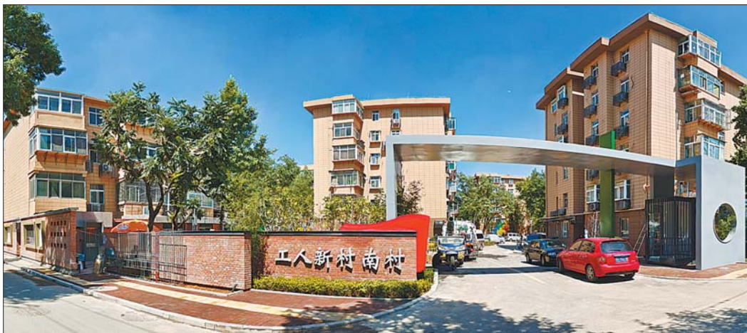
工人新村南村城市更新改造后的效果。
