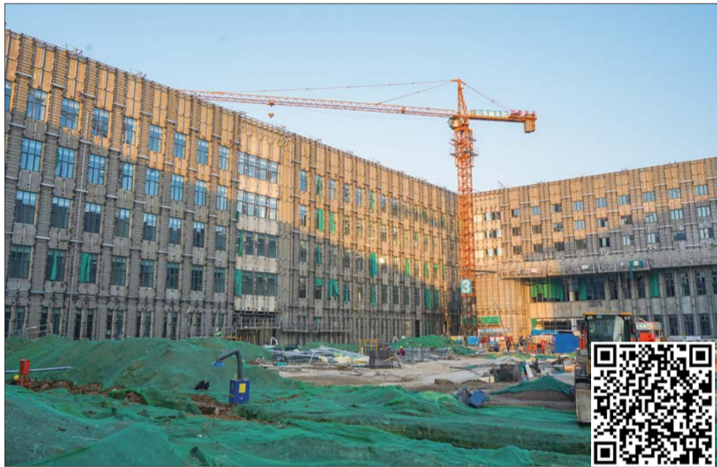
项目正在进行外立面装饰装修。
