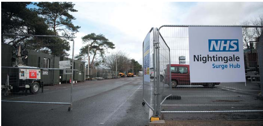
这是1月2日在英国阿什福德拍摄的建设中的临时医院。 新华/法新
