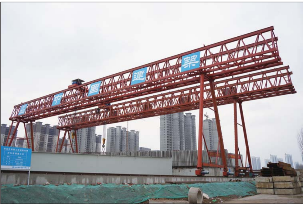
渔皇路跨老运河桥项目施工现场。
