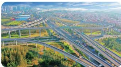
圈配置导则》。制定《内环高架沿线规划管理暂行规定》《大运河济宁段核心监控区国土空间管控暂行规定》,全面提高城市精细化管理水平。
