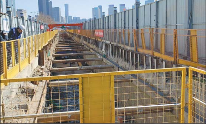
奥体中心站施工现场800多根钢管支撑路面,确保万无一失。
