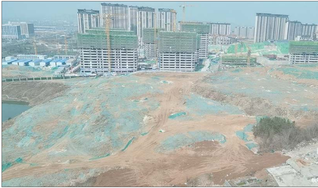
近期高铁城X-2配建小学地块工地现场。
