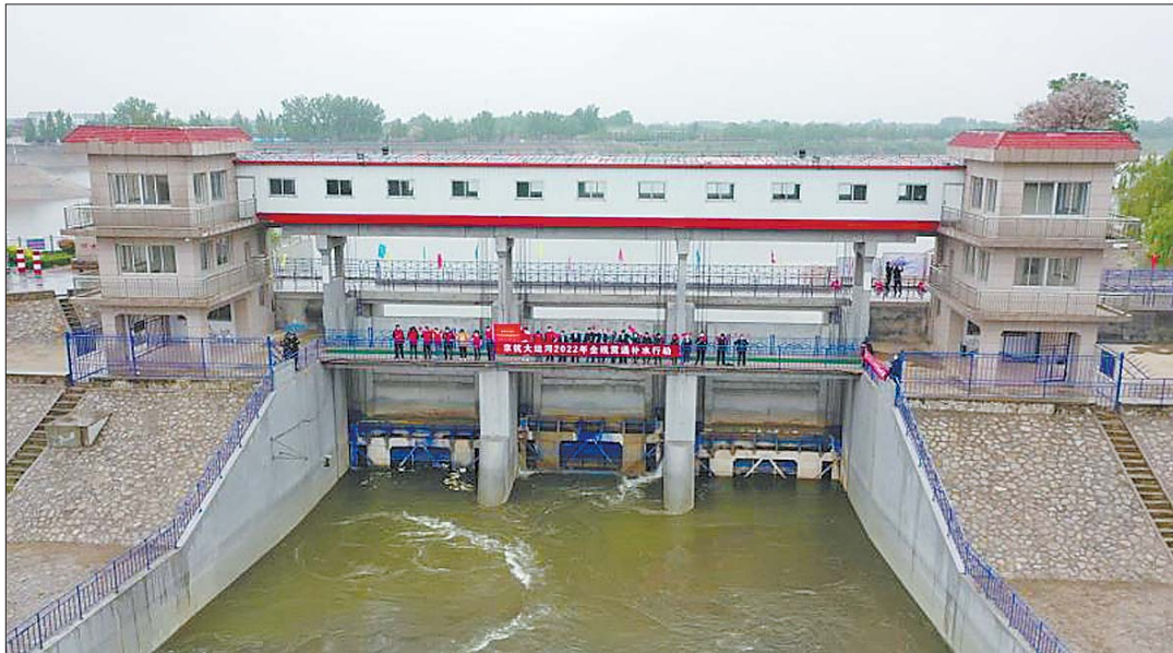
4月28日,德州市四女寺枢纽南运河节制闸开启,对京杭大运河全线贯通补水。
