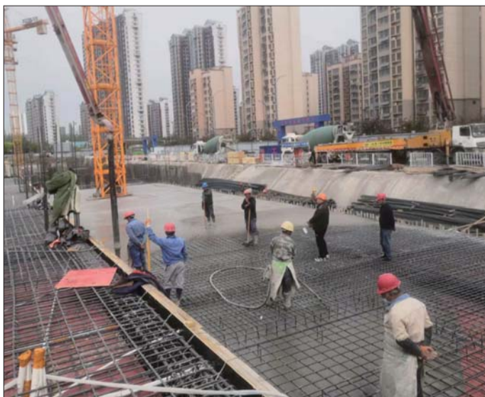
太白湖电子科教基地项目施工现场。
