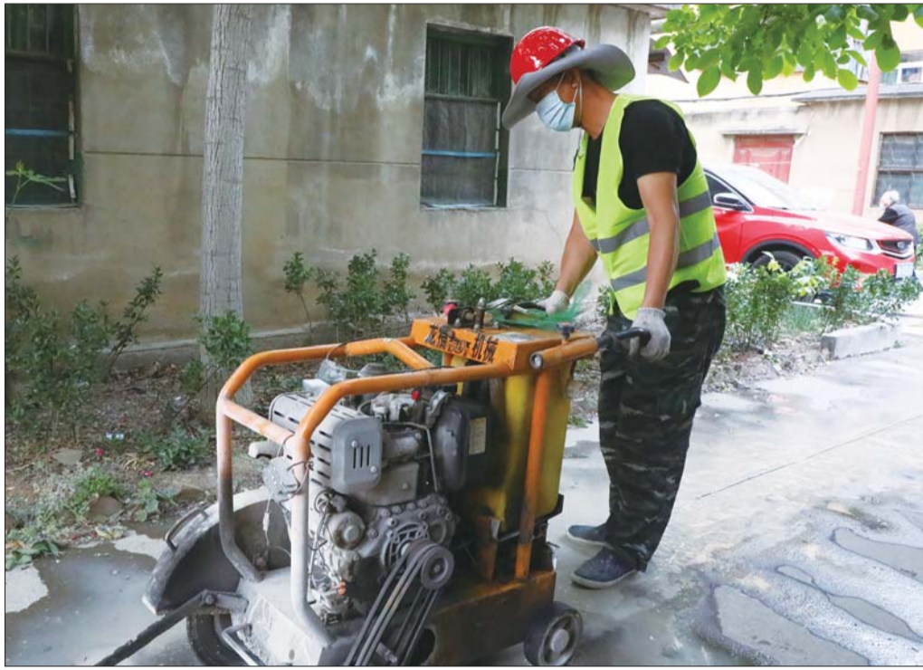
雨污分流改造工程施工现场。
