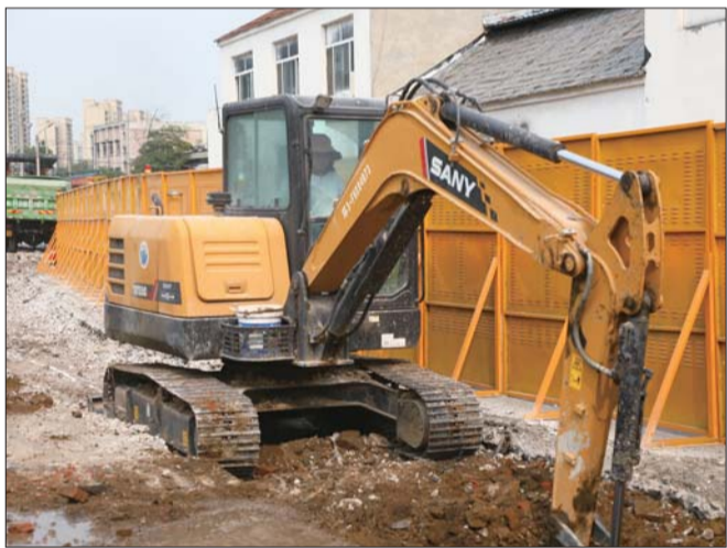
挖掘机正在进行路面开槽作业。
