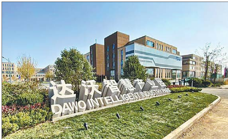
济阳区工业项目加快建设，工业企业高位运行。
