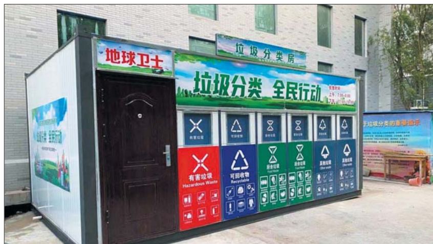
因地制宜推进撤桶并点,建设分类亭632处、密闭分类房40处。
