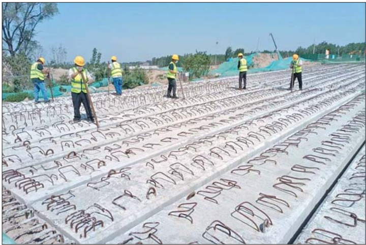
商西路133桥桥面施工。
