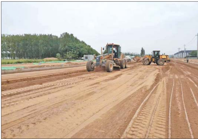
G2南连接线项目，人员、设备、材料齐到位，开足马力抢生产。
