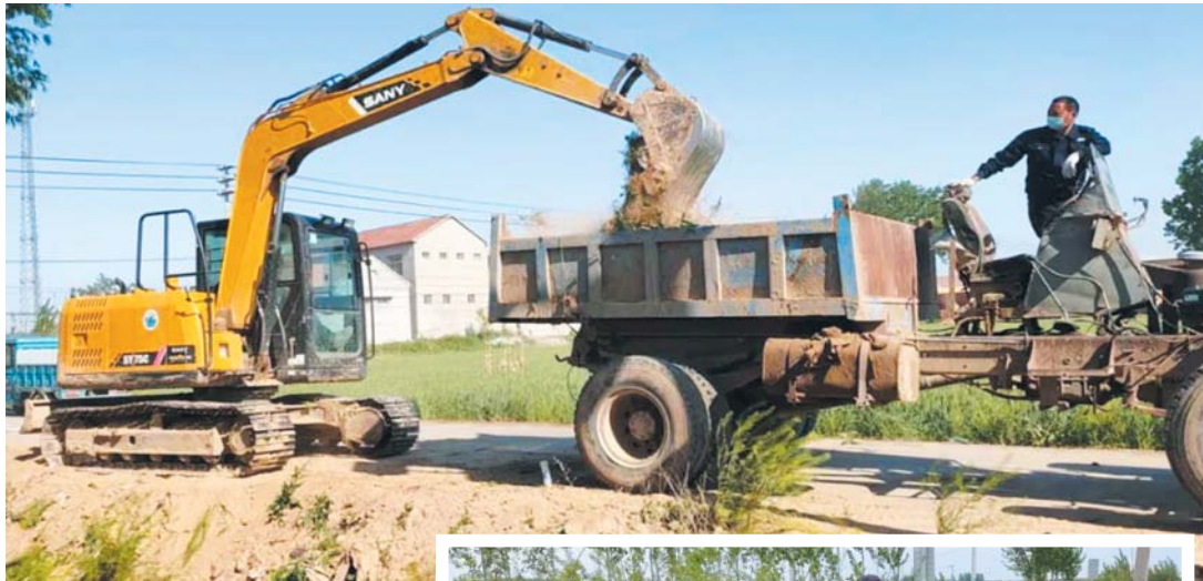
▲动用大型机械，对排水沟内淤积物进行清理。
