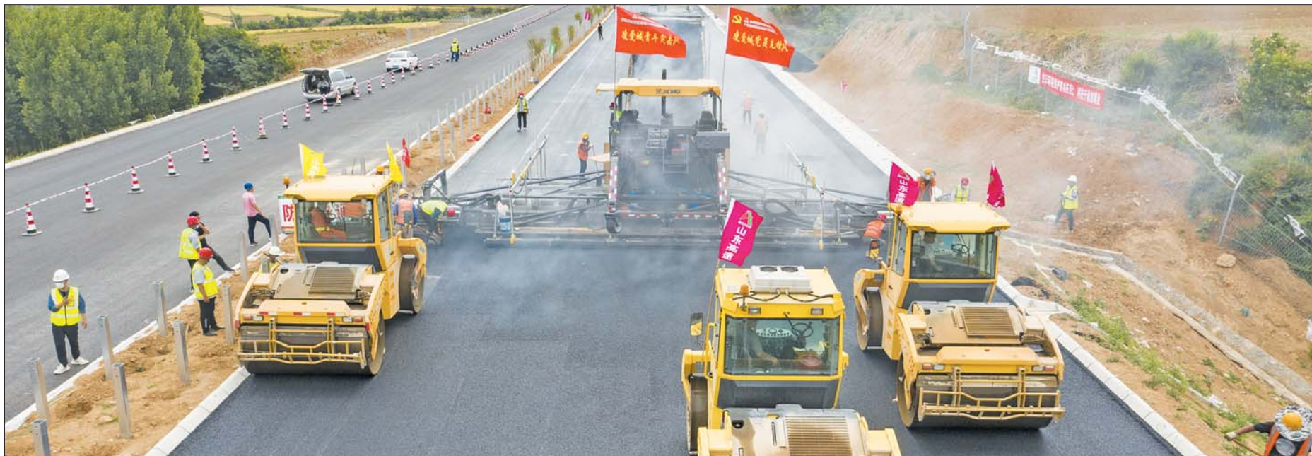
施工黄金季,济南多个重点交通项目建设按下“快进键”。
