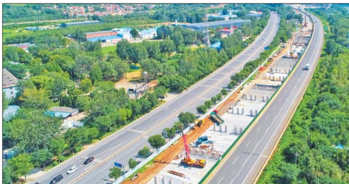
京台高速济泰段改扩建稳步推进。
