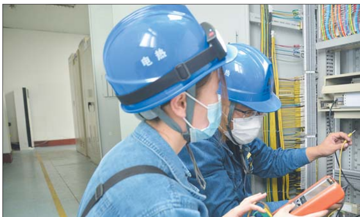
工作人员在进行设备调试。
