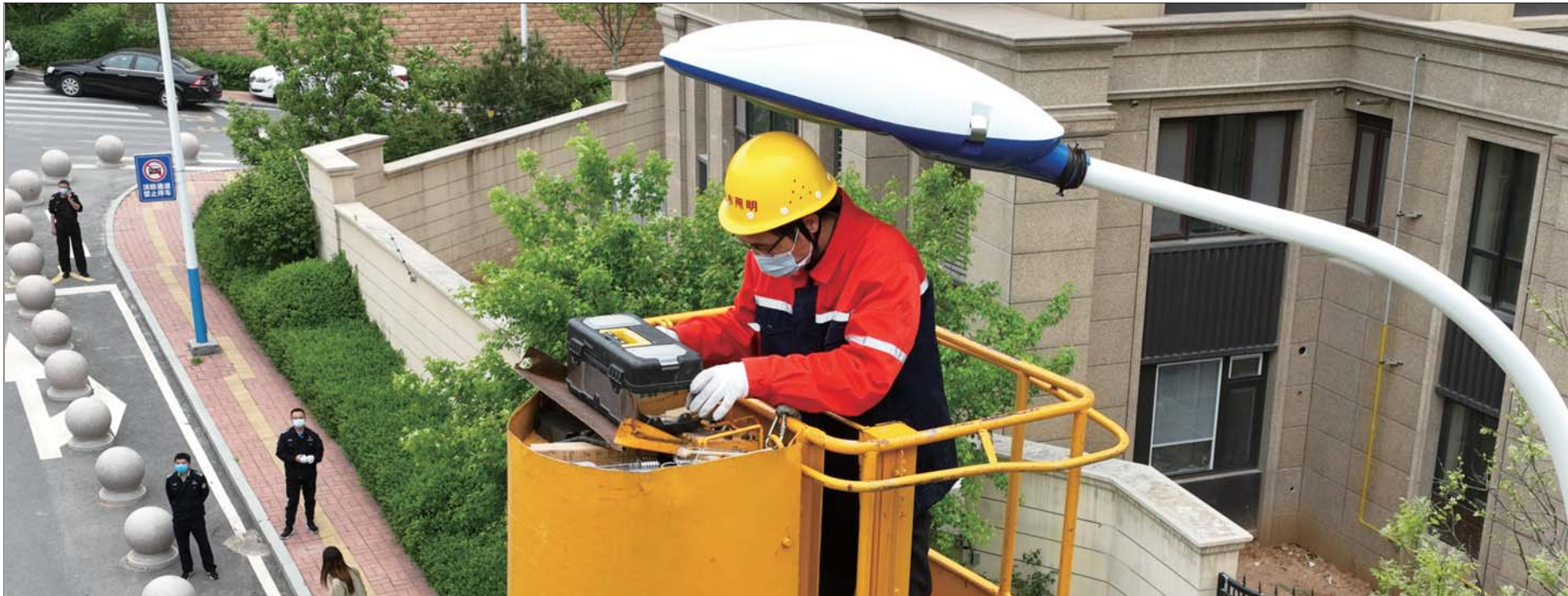
济南市城市照明服务中心工作人员在进行灯具维护。
