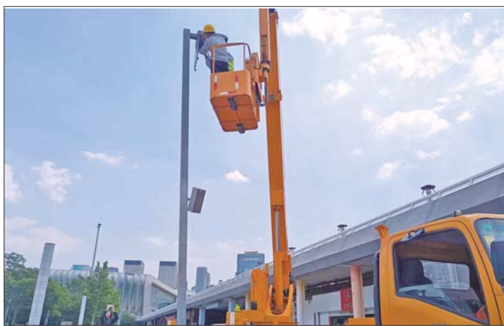
工作人员在更换光源。
