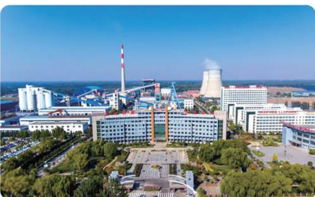
济宁能源阳城煤电循环经济示范园区。
