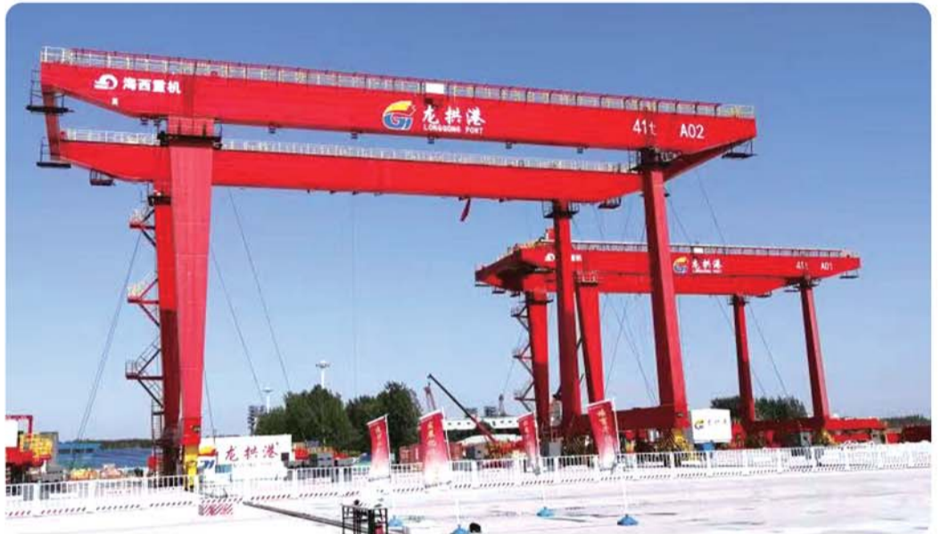
济宁能源正在建设中的龙拱港集装箱多式联运项目。
