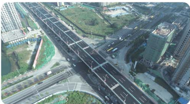
吉安桥路与车站西路路口立体化改造项目。
