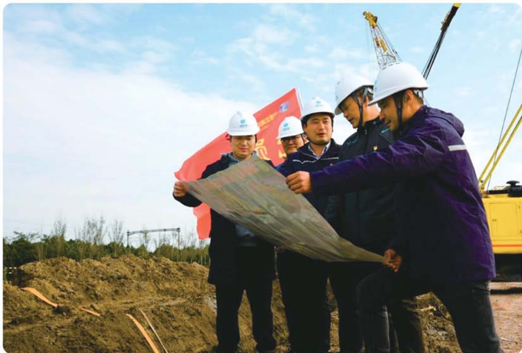
山东公用热电集团保障民生供暖,推进热源替代工程。
