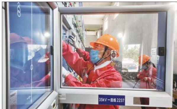
员工在110千伏东一变电站检修。通讯员 张京波 摄
