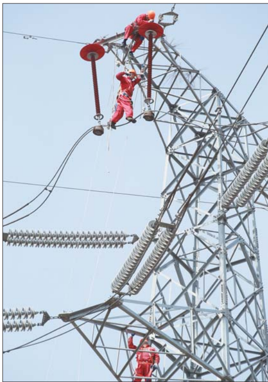
员工在220千伏万九I线更换绝缘子。 通讯员 赵宁 摄
