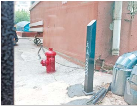
新安装的门禁设施。
