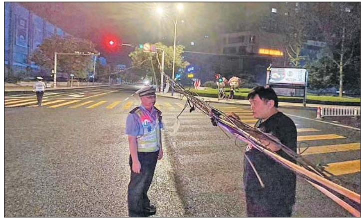
交警配合工程人员清障，消除安全隐患。
