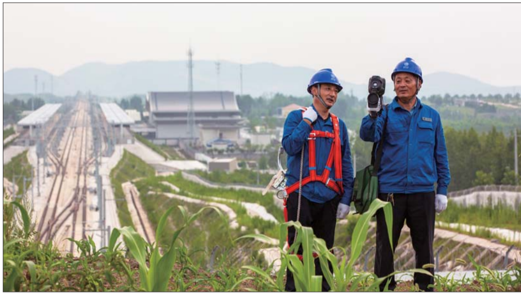
国网泗水县供电公司组织人员排查线路隐患，保障可靠供电。
