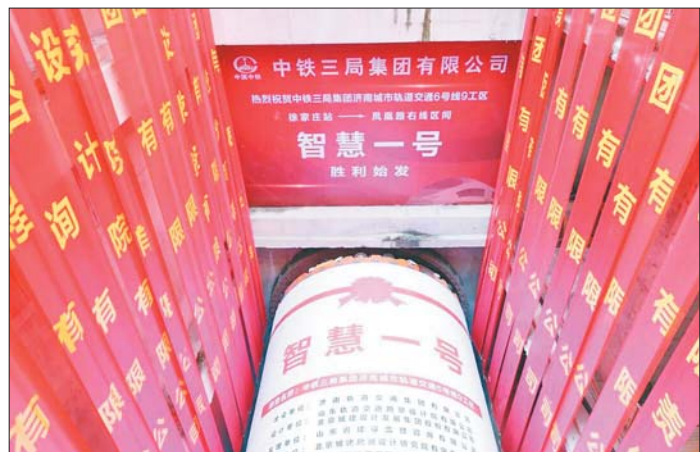
9月17日,“智慧一号”盾构机在6号线凤凰路站始发,标志着“济南造”智能盾构正式进入工程应用阶段。 济南轨道交通集团供图
