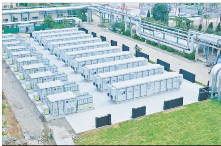
2022年8月,对华能首座百兆瓦级分散控制储能电站周边绿化美化。
